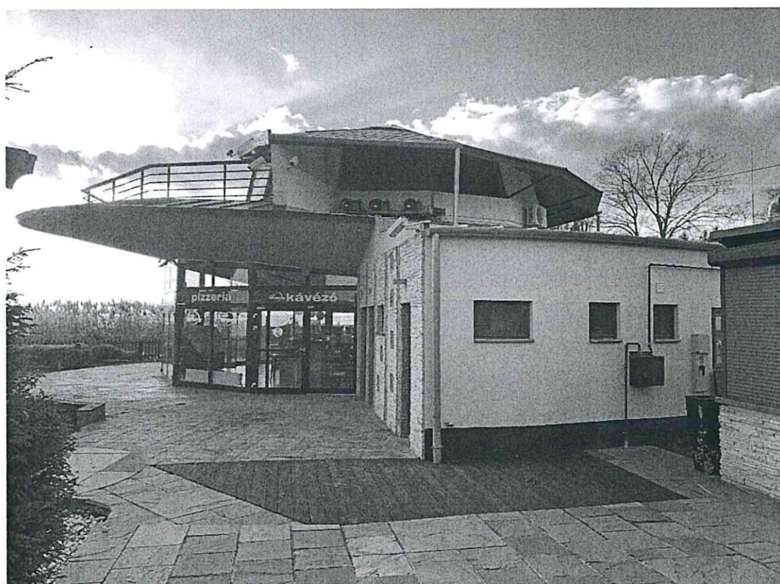
A „körpresszó” (egykori révi állomás) épület 2021 elején – saját felvételek
